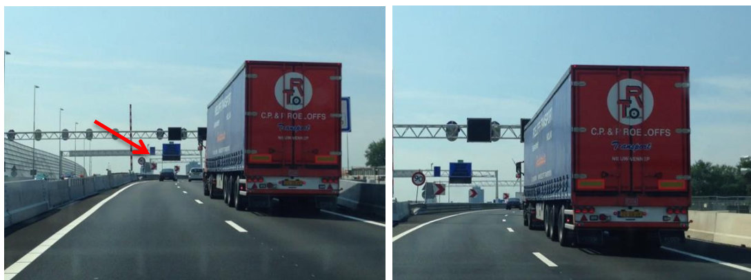
Figuur 2.6: Parallax-effect door bewegwijzeringsbord naastgelegen rijbaan bij tijdelijke situatie Tweede Coentunnel (Lambers, 2013b).
